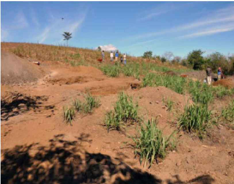
Figura 3-1. Empezando Operación Oeste.
